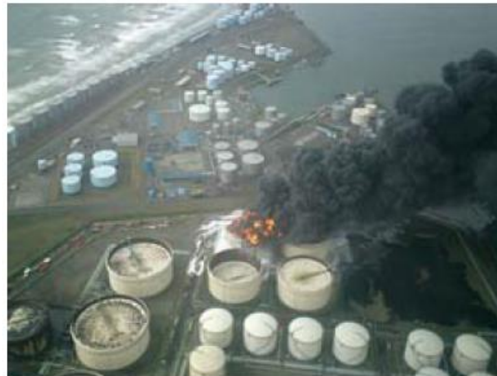
2003年十勝沖地震 石油タンクのスロッシングによる火災
