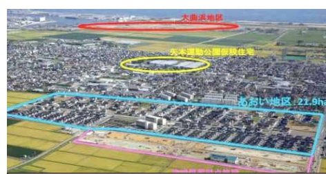
写真7) 防災集団移転地あおい地区
