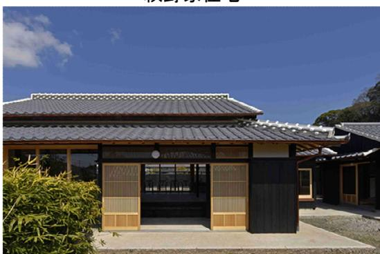
【施設の概要】当住宅は「重要伝統的建造物群保存地区」である安芸市土居廓中にあった空き家を改築して建てられた住宅です。設計・工事ではできるだけ既存の部材を残し、生かしています。各部の納まり（瓦屋根部分等）は当時の工法で施工されており、黒色塗料を用いることで新旧の部材の調和を図るといふ工夫もされています。また、大工・左官・瓦などの主要な工事をはじめ、安芸の職人さんが全ての施工をすることで、伝統の技術を後世に受け継ぐことにも寄与しています。
