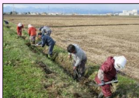
水路の泥上げ
