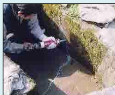
ひび割れの補修
