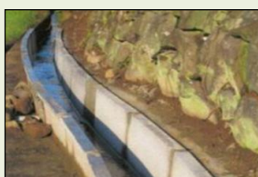
素堀り水路からの更新
