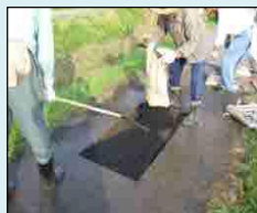
農道の部分補修
