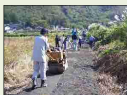
未舗装農道の舗装
