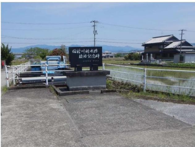
⑧田村川排水路
