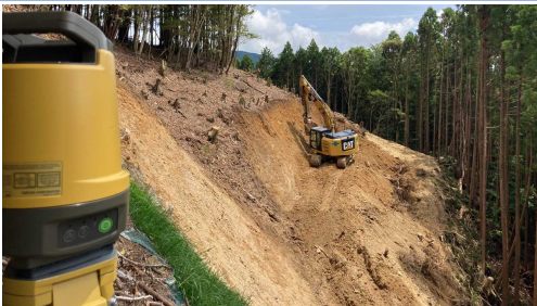
杭ナビ ショベル による ICT施工
