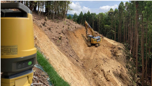
杭ナビ ショベル による ICT施工
