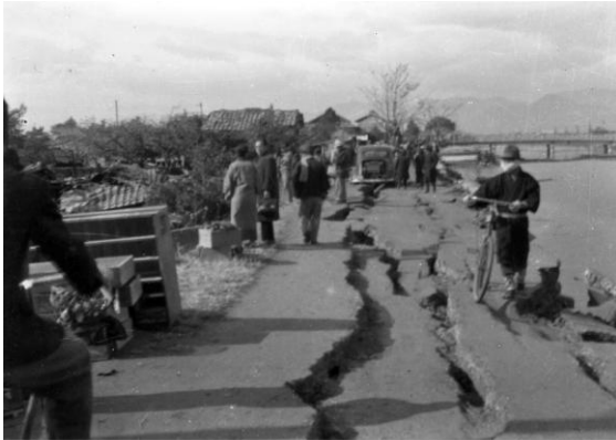
5. 高知市江ノ口川南岸. 堤防の地割れ. 21.12.22
