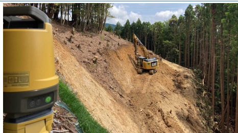
杭ナビ ショベル による ICT施工
