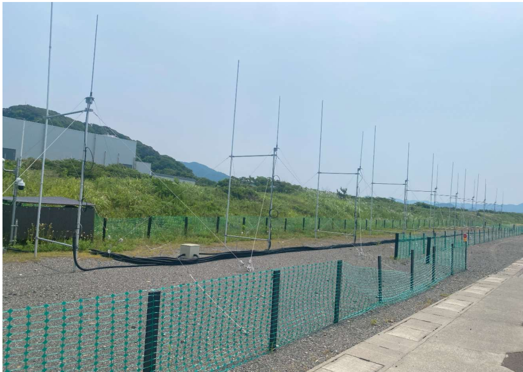
福井県三方郡美浜町のレーダー局設置風景
