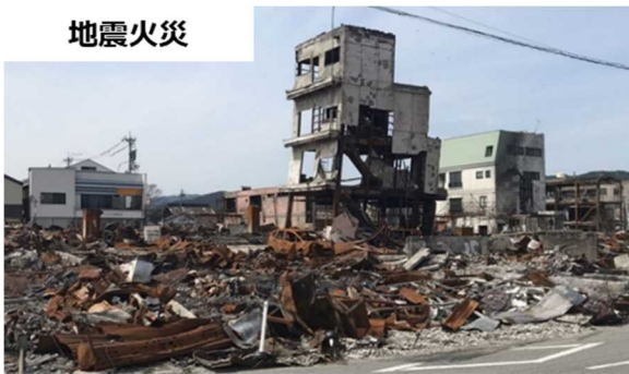
輪島市河井町 朝市地区 令和6年4月7日撮影
