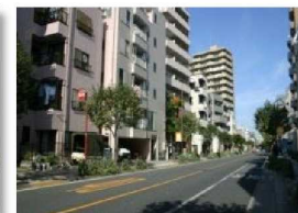
沿道建築物の不燃化
