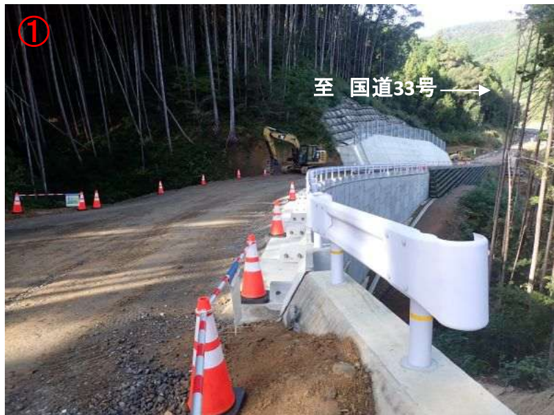
国道33号から300m付近までの整備状況 (令和7年11月撮影)
