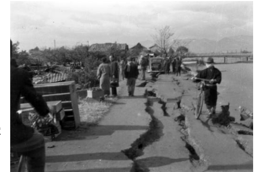
(右図) 昭和南海地震による高知市内の液状化被害 (高知大学沢村・上田先生による)
