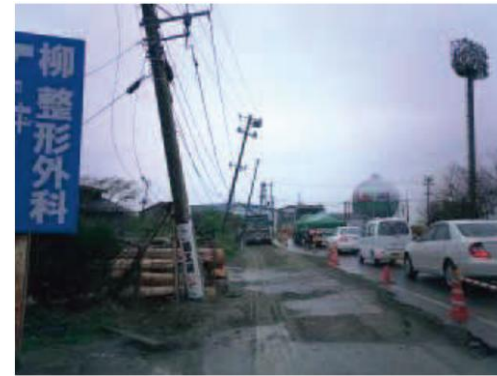
(左図) 2004年新潟県中越地震による電柱の沈下、傾斜と道路の性状
