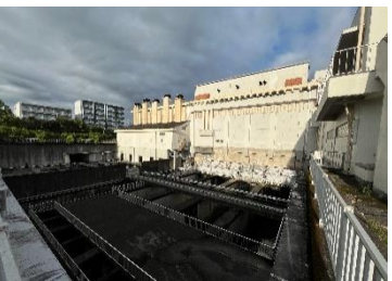
▲海老ノ丸ポンプ場
