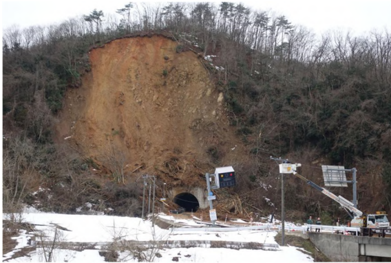
石川県能登町内での土砂災害
