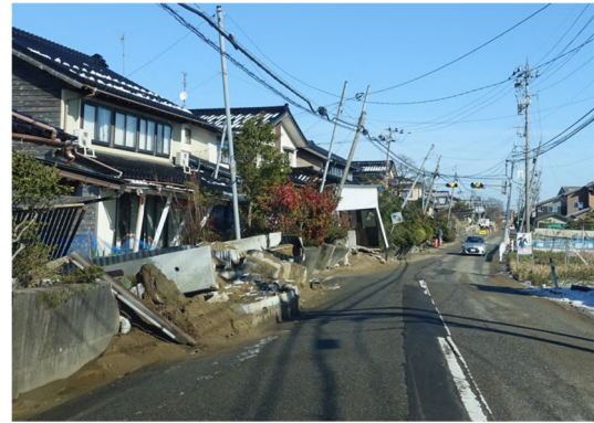
石川県内灘町内での液状化現象
