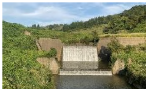
旧山古志村東竹沢地区の砂防堰堤
