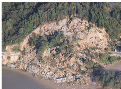
土砂災害による道路寸断
