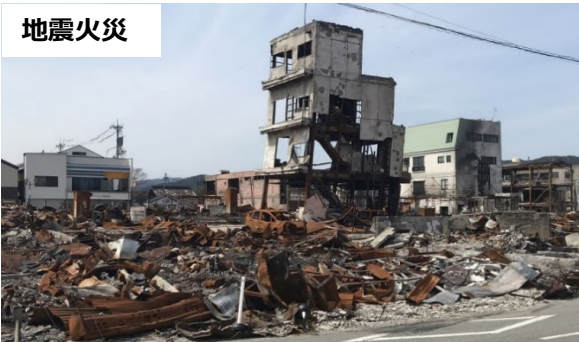
輪島市河井町 朝市地区 令和6年4月撮影
