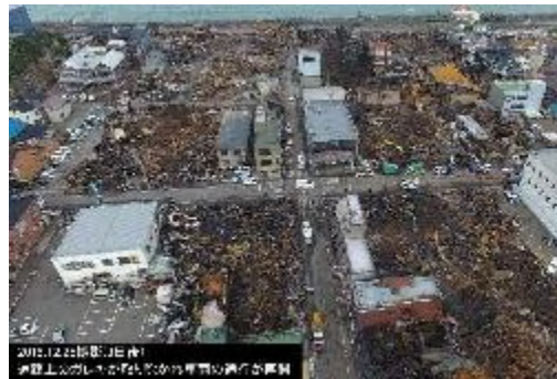
出典:国土交通省 新潟県糸魚川市「糸魚川市 駅北大火からの復興まちづくり」
