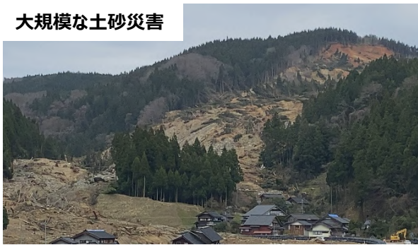
輪島市市ノ瀬町 令和6年4月撮影
