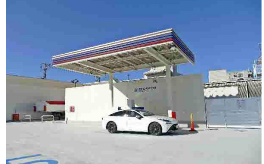
高知水素ステーション
