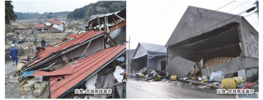
【東日本大震災の建物被害】
