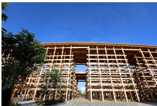
写真4 大屋根リング（外観）
