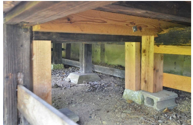
写真 2.1.3 床束の応急処置
