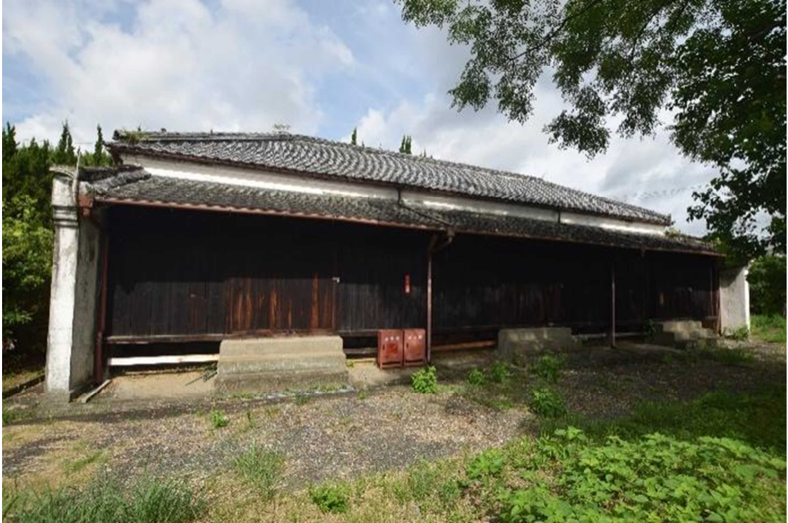
口絵1 弾薬庫東面外観
