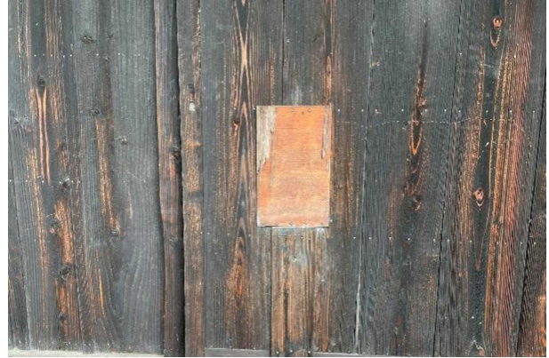
写真 2.1.20 框戸の破損
