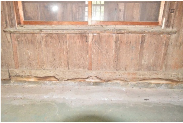
写真 2.1.32 巾木の腐朽
