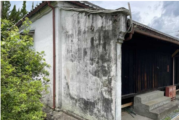
写真 2.1.6 袖壁の汚損
