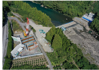
【北川道路 2-2工区】 (8の字ネットワークの整備)
