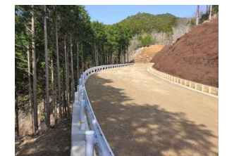
【林道旭・天狗高原線(仁淀川町)】 (林道の整備)
