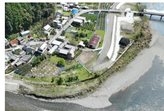
【安芸川】 (河川の堤防整備)
