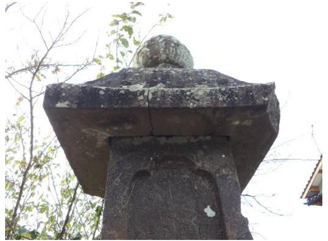
笠部欠損・割れ
