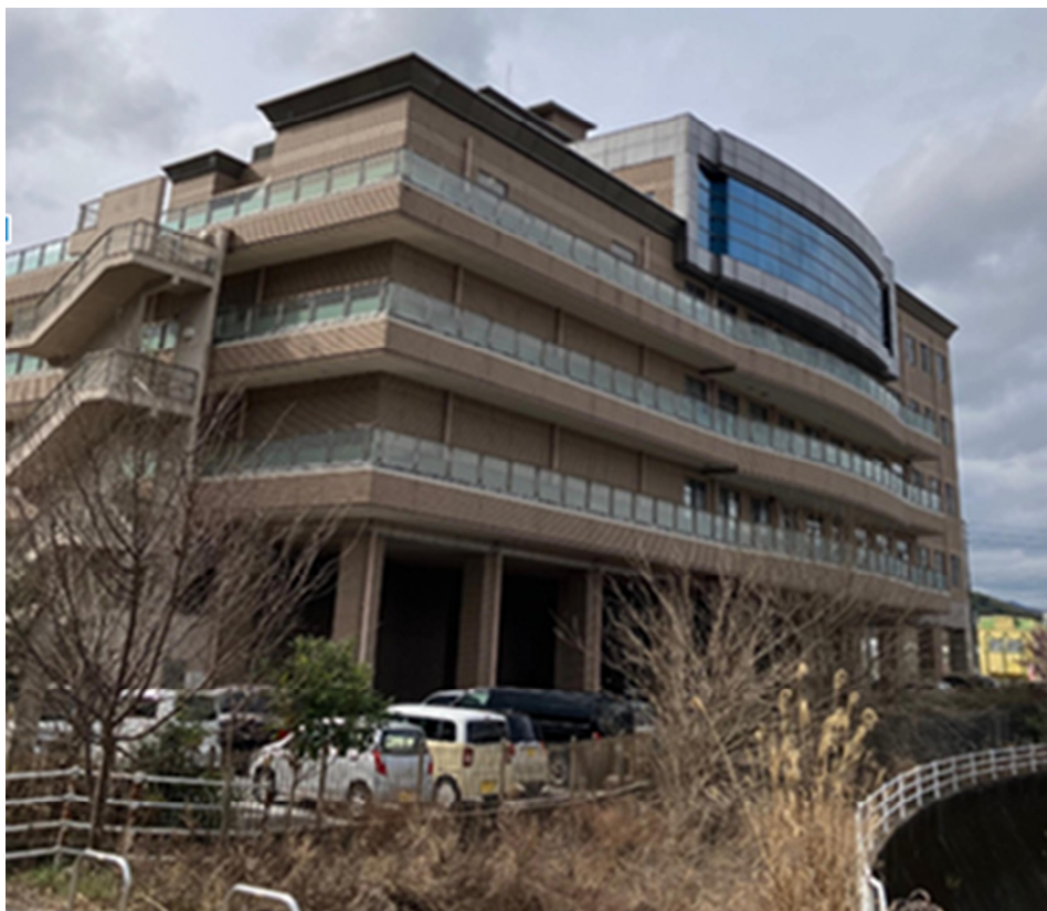
[建物外観：背面写真]
