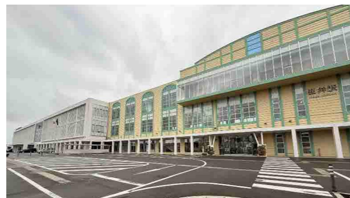
市役所を併設する駅 (山形鉄道長井駅)
