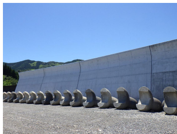
安和漁港海岸高潮対策工事 （須崎市）
