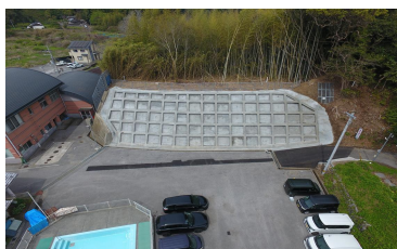
十市地区急傾斜地 崩壊対策工事（南国市）
