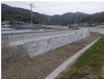
和食川改修工事（芸西村）
