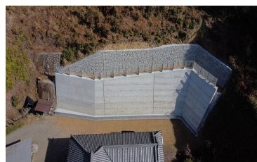
がけくずれ住家防災対策工事 （須崎市）
