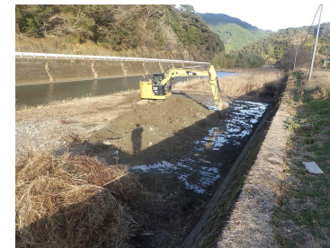
下ノ加江川浚渫工事（三原村）
