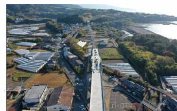
南国安芸道路整備（安芸市）
