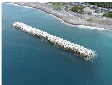
穴内漁港海岸侵食対策工事 （安芸市）
