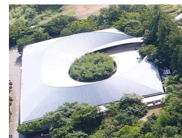
本館屋根の改修
