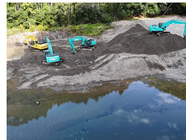
永瀬ダム浚渫工事（香美市）
