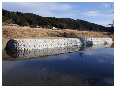
与津地川改修工事（四万十町）
