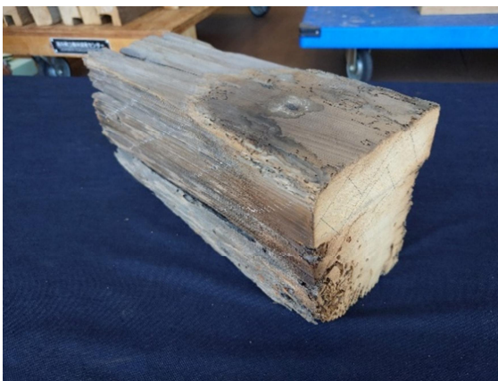
図1 歴史建築物の構造部材（破棄材端部）
