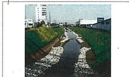
⑥河川・水路における自然浄化対策 自然石による護岸とし、生物の生息空間を確保した。(厚木市恩曾川)
