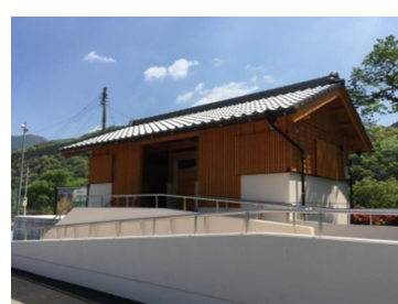
屋外景観施設（トイレ）
