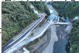
国道493号2-2工区（北川村）
