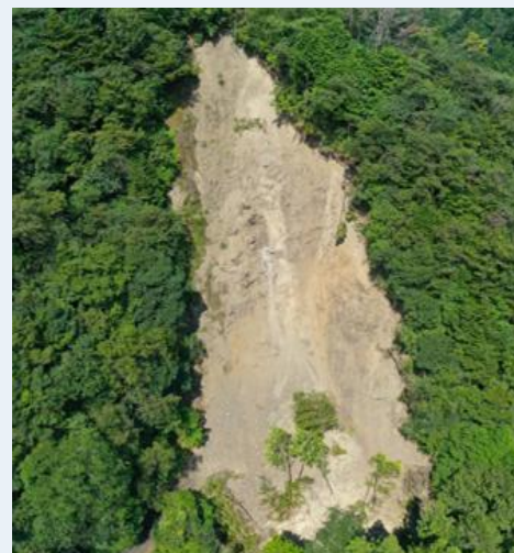
ドローンにより災害現場の 全容を迅速に把握
