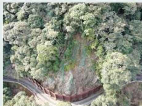
県道清王新田貝ノ川線 藤ノ川工区
