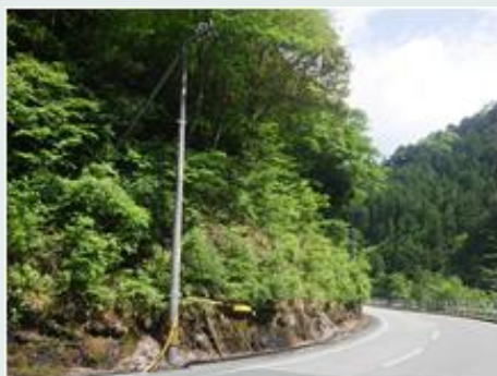
国道194号 いの工区
