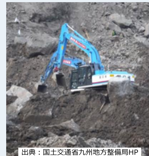
災害現場で活躍する 遠隔操作式のバックホウ
