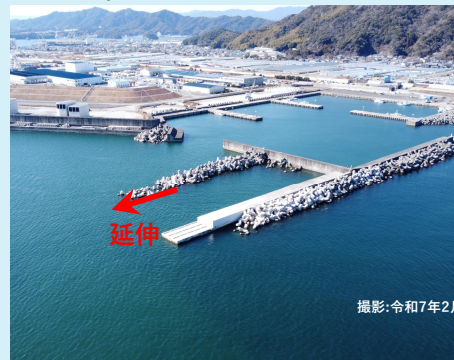
高知港 東第2防波堤
