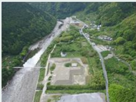
国道493号 北川道路2-2工区 (和田工区)
