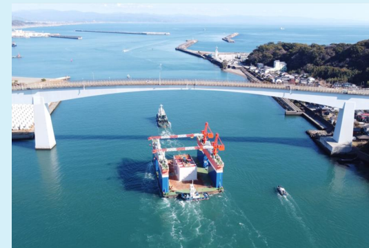
施工状況(運搬)
