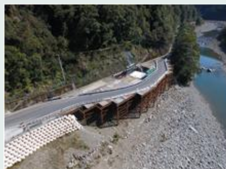
国道493号 北川道路2-2工区 (柏木工区)
