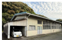
中村校 実習棟(溶接)【築56年】
