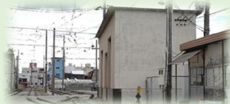
[写真] 後免変電所
