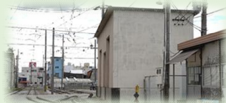
[写真] 後免変電所
