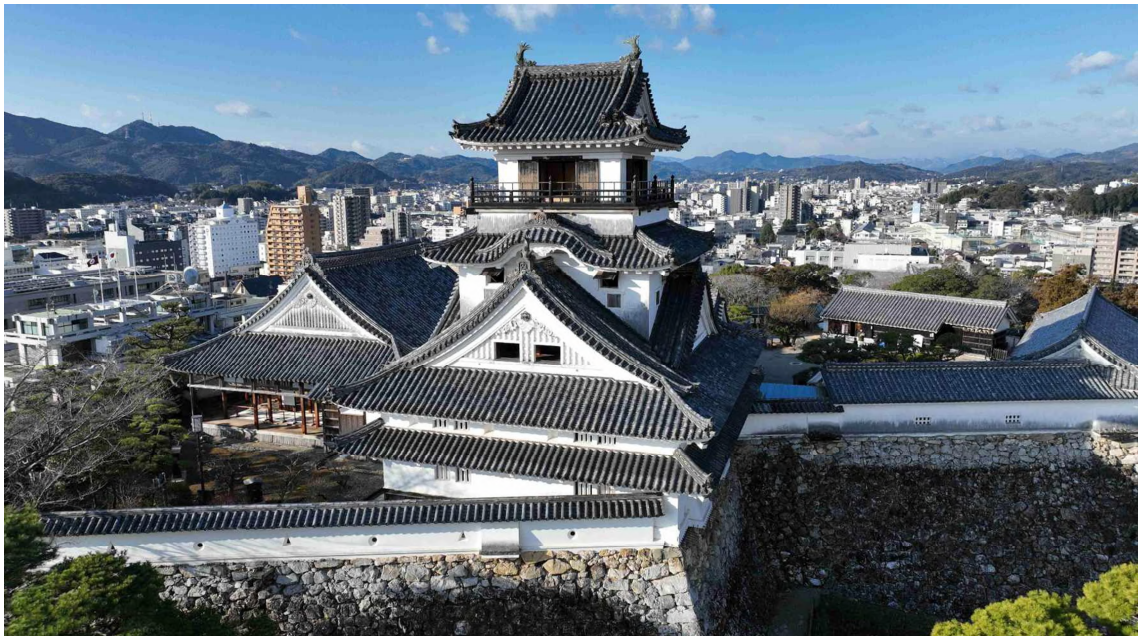
本丸 北東より見る
