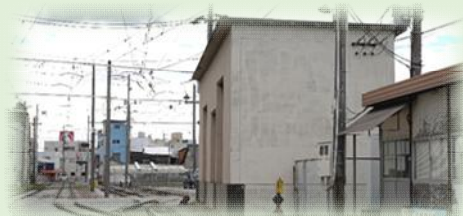
[写真] 後免変電所
