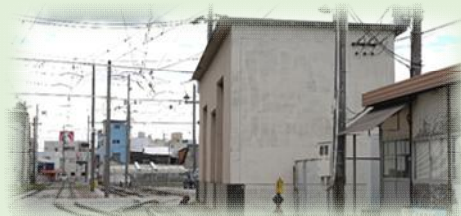
[写真] 後免変電所
