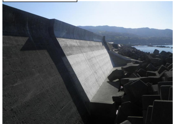
堤体の補修とともに補強
