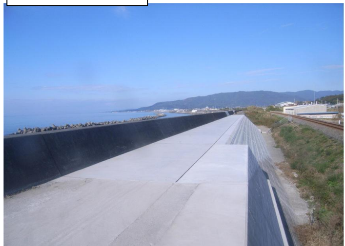
堤体の補修とともに補強
