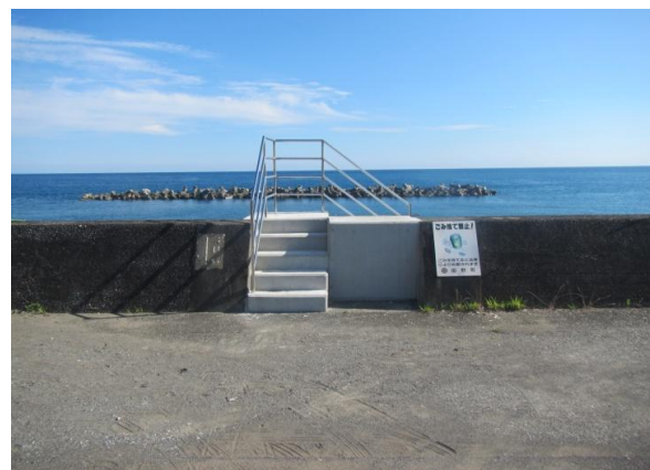
利用の状況に応じて階段を整備
