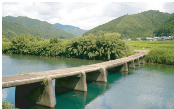
一斗俵沈下橋（四万十町）
