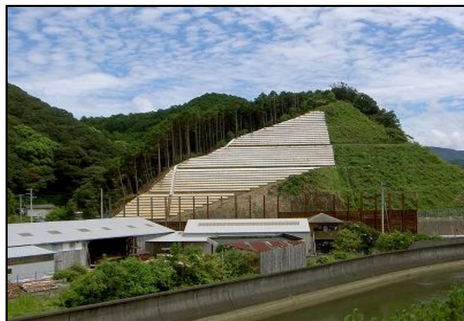
道交国自主(防災)第14-276-1号 国道321号地域自主戦略交付金工事
