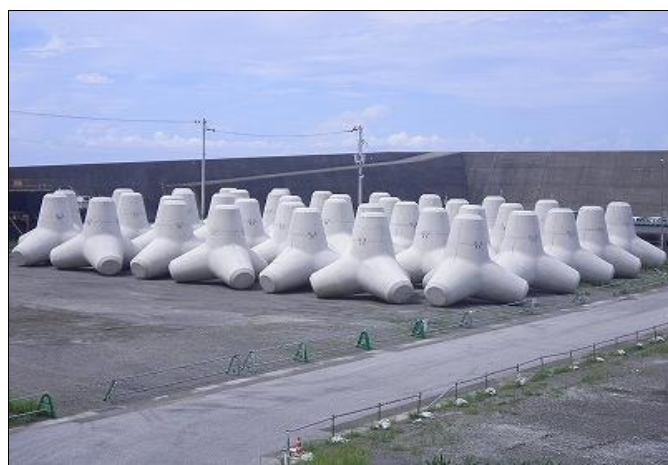
漁生産第12-2号 加領郷漁港水産生産基盤整備工事
