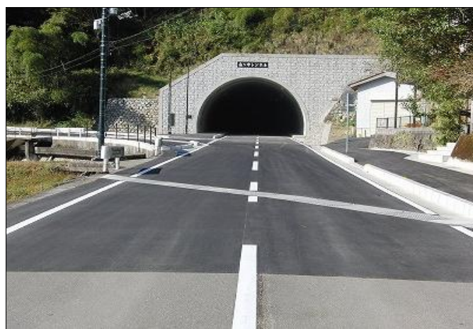
道交地(改築)第101-220-2号 県道窪川船戸線社会資本整備総合交付金工事
