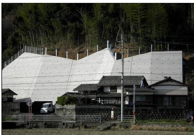
急傾第13-1-23号 森間古急傾斜地崩壊対策工事
