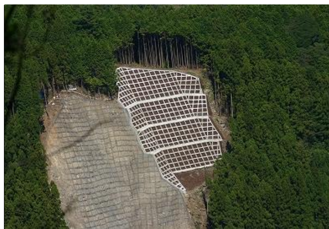
23災第3-1号 一般国道494号道路災害復旧工事
