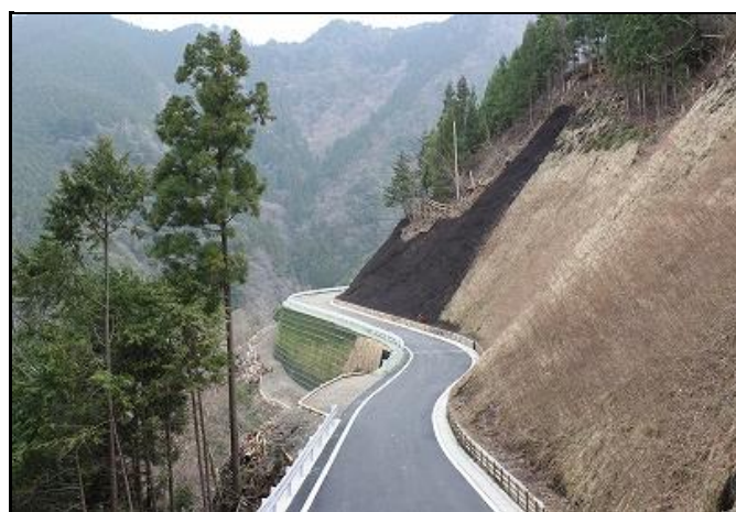
道交基幹第15号 森林基幹道開設事業河口落合線6工区工事
