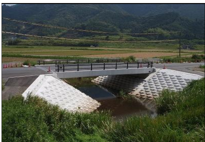
道交地自主(交安)第12-079-2号 県道宗呂中村線活力創出基盤整備総合交付金工事
