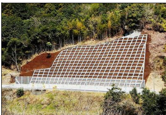
道改(特定)第07-08-3号 県道谷地日下停車場線道路改良工事
