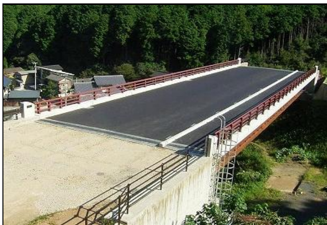
道交国(改築)第109-215-12号 国道494号活力創出基盤整備 総合交付金(小濱谷橋上部工)工事
