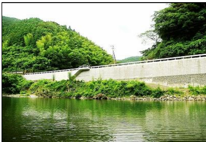
道交地(改築)第101-222-2号 県道中平橋原線活力創出基盤整備総合交付金工事
