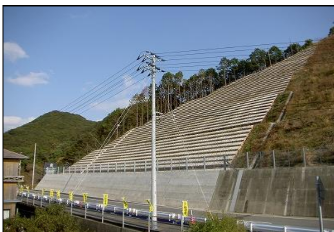
道交国自主(防災)第14-276-2号 国道321号地域自主戦略交付金工事
