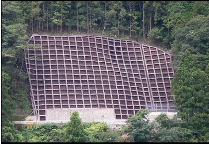
23災第4-2号 県道庄田伊野線道路災害復旧工事
