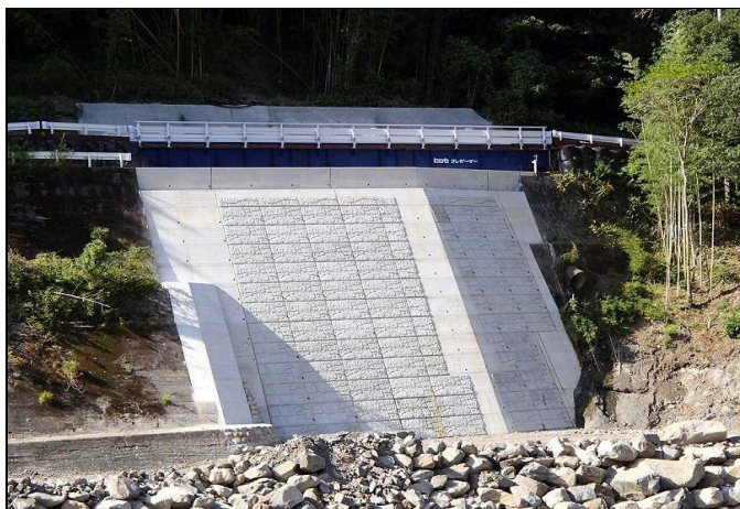
23災第478-3号 国道493号道路災害復旧工事
