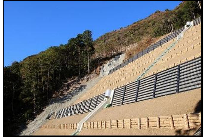
復旧第4号 勝賀瀬復旧治山工事
