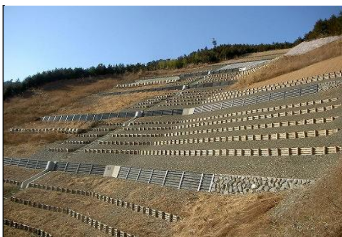
復旧第5号 西川復旧治山工事
