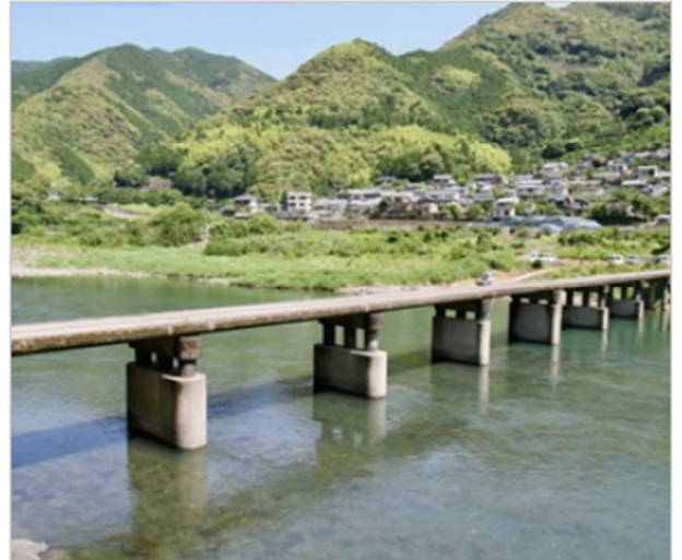
浅尾の沈下橋 （越知町）
