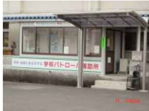
朝倉第二小学校に設置している学校パト ロール隊詰所の模様
