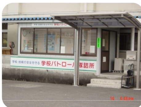
朝倉第二小学校に設置している学校パトロール隊詰所の模様
