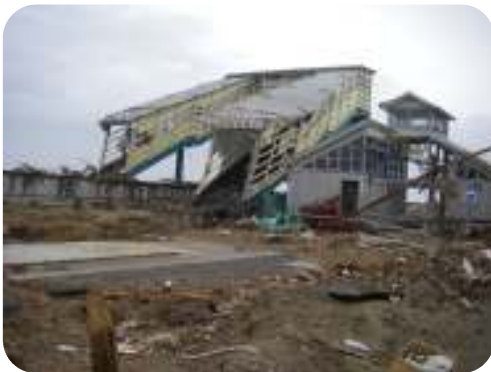
東日本大震災で被災した常磐線 坂元駅
