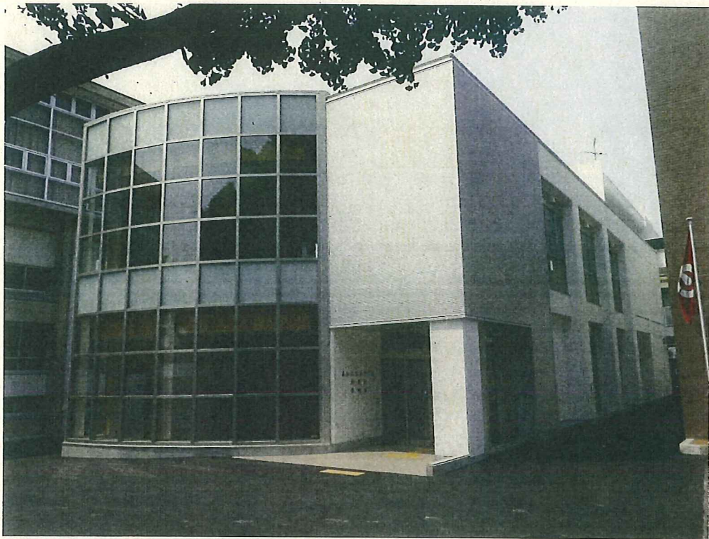
完成 外観（北東側より）
