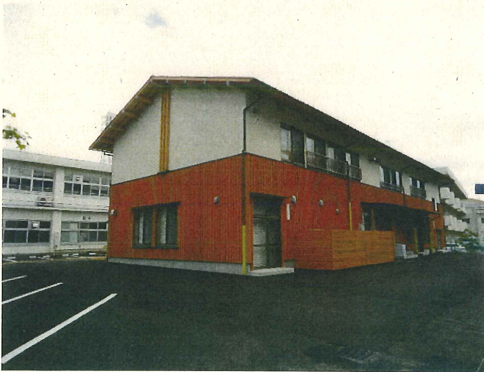
南舎 外観（南西）完成
