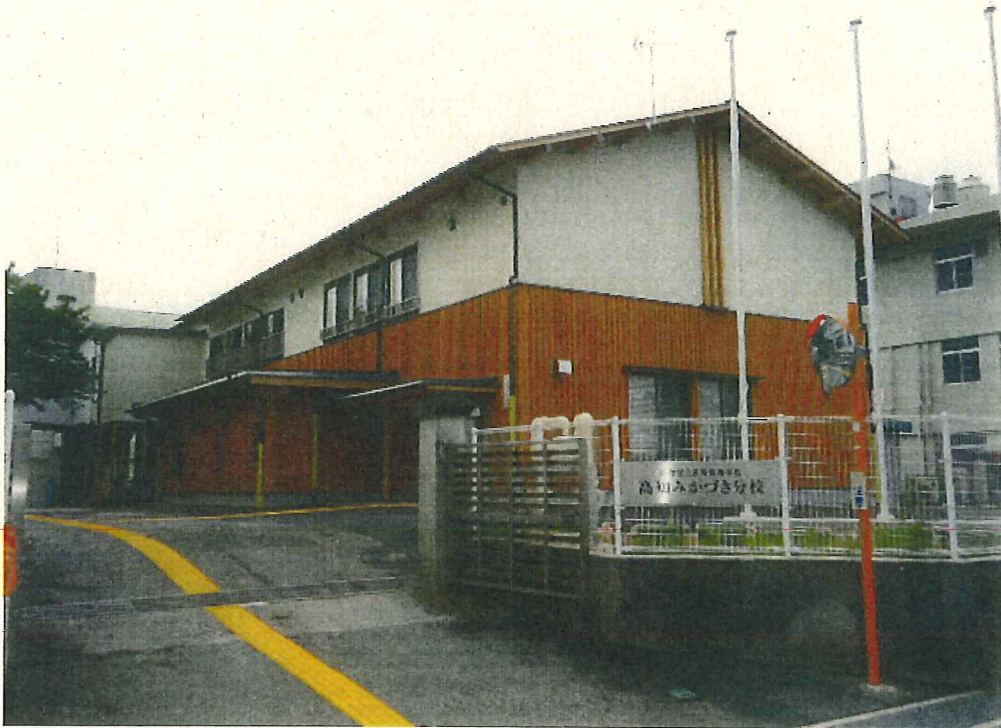
南舎 外観（北西）完成
