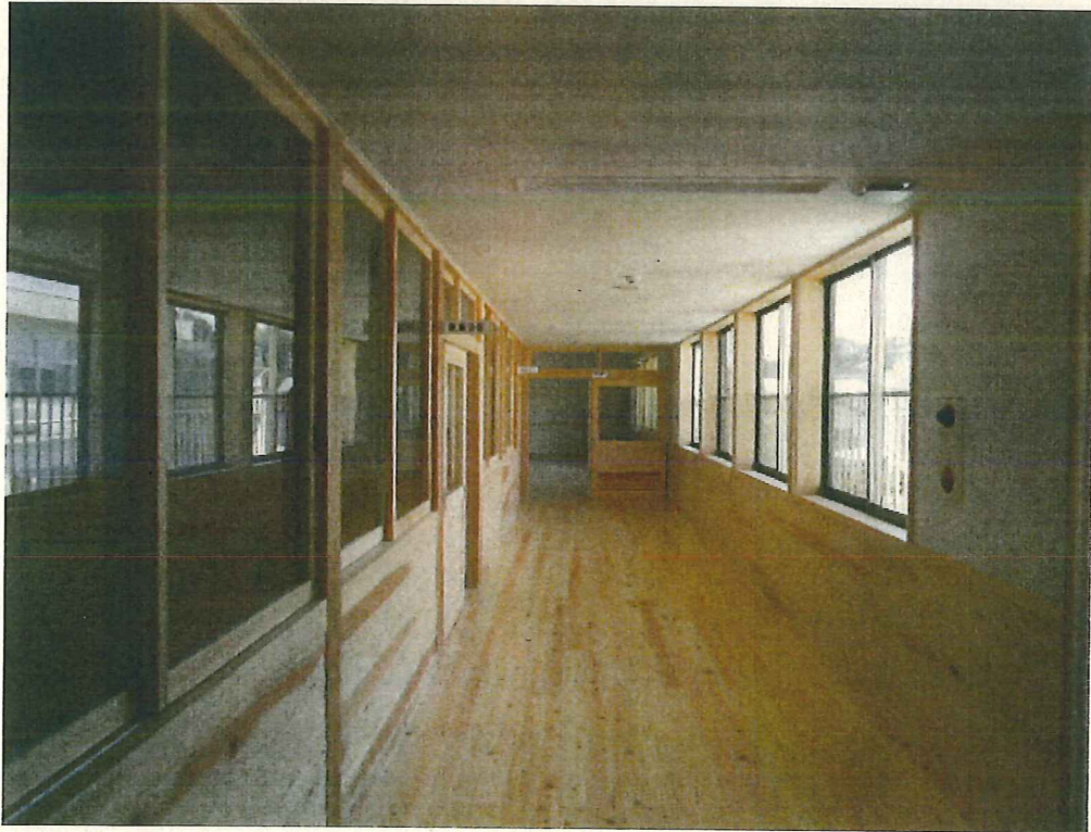
南舎2階 廊下 完成
