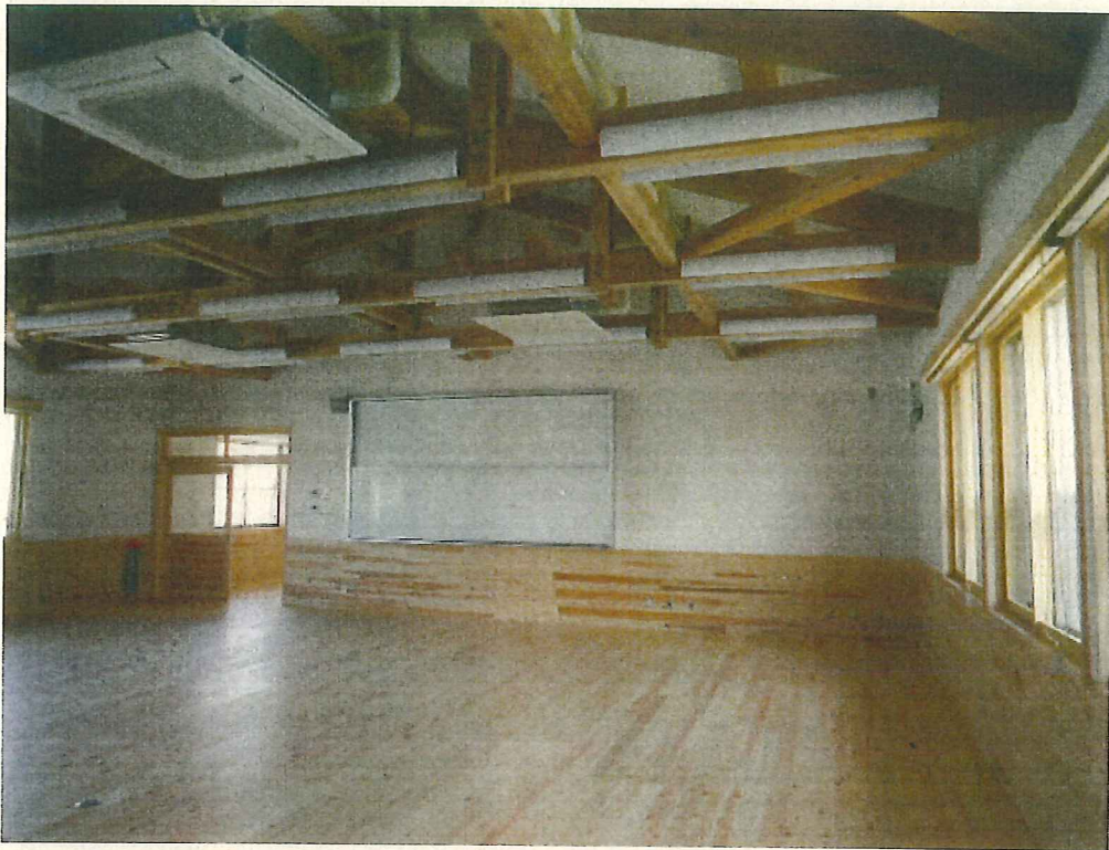
南舎2階 総合実習室4 完成
