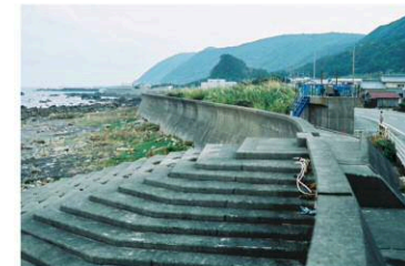
〔緩傾斜堤(室戸市丸山海岸)〕
