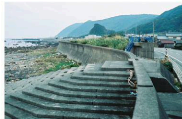
〔階段式護岸堤(室戸市丸山海岸)〕
