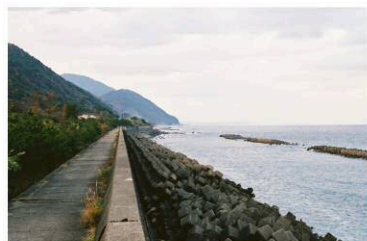
〔消波工と離岸堤(室戸市根丸海岸)〕
