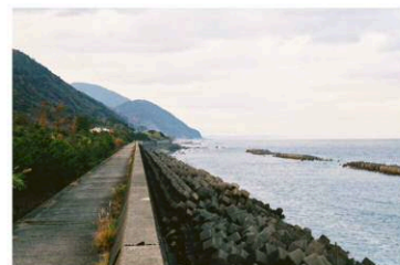
〔消波工と離岸堤(室戸市根丸海岸)〕
