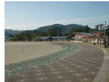
〔甲浦港海岸・白浜地区（東洋町）〕
