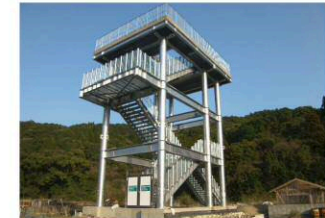
〔津波避難タワー (四万十町)〕
