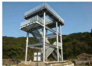
〔津波避難タワー (四万十町)〕
