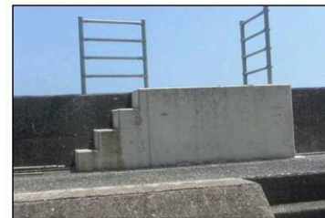
〔陸閘常時閉鎖 事例〕
