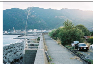
③護岸状況
